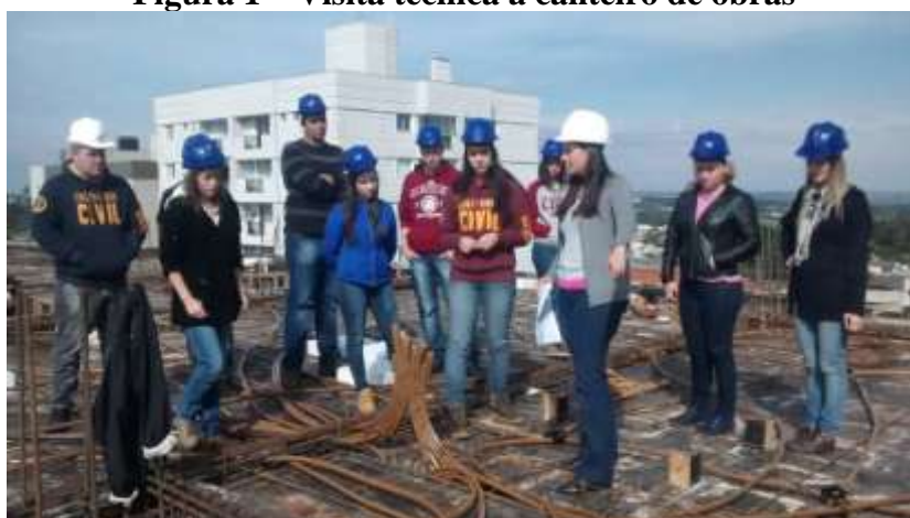
Figura 1 – Visita técnica a canteiro de obras
