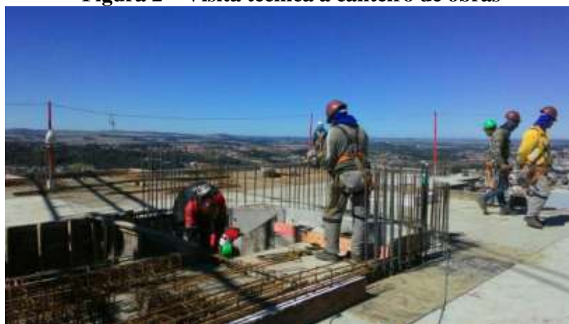
Figura 2 – Visita técnica a canteiro de obras
